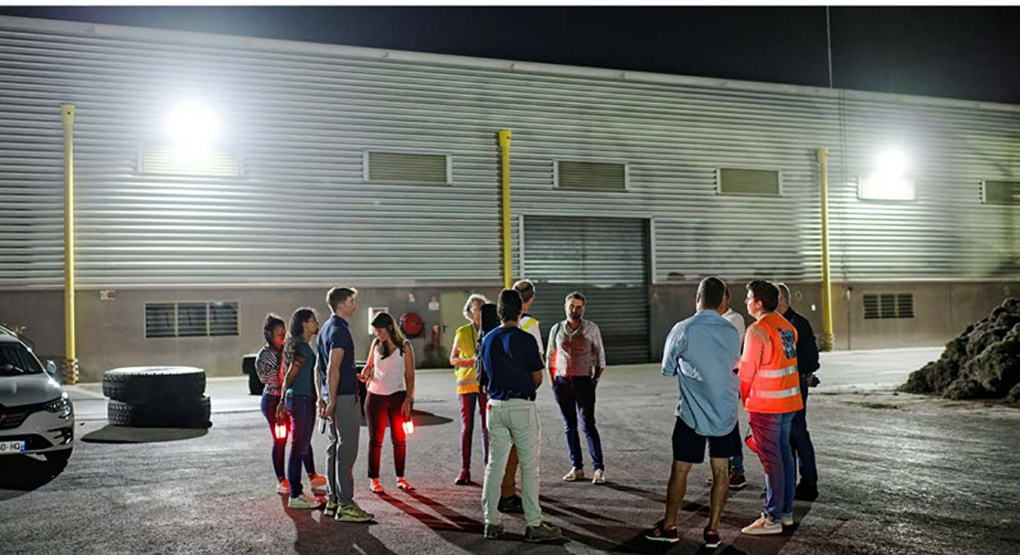
Diagnostics d'éclairage sur sites industriels.
